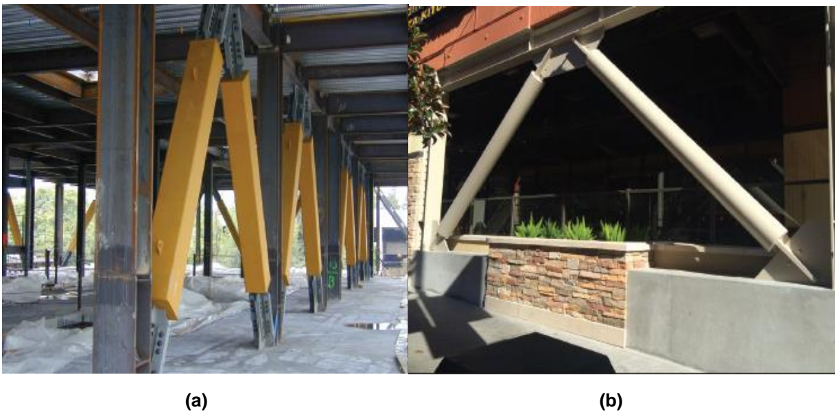
Figura 2.36 - (a): BRB del proveedor Nippon Steel; (b): BRB del proveedor CoreBrace [56]
