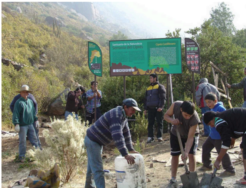
(Figura 18: Instalación de Señalética de Santuario)
