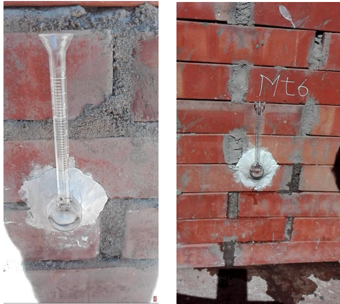
Figura 4.18: Ensayo Tubo Karsten
