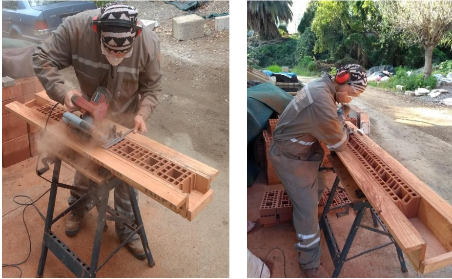
Figura 3.5: Proceso de modificación de los ladrillos
