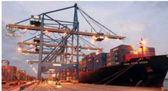
Grúas Pórtico Post-Panamax
