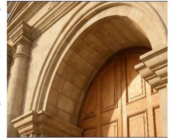
(fig 59) Detalle pórtico
