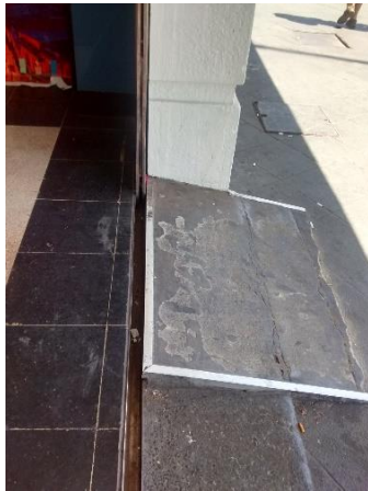
Rampa instalada post obra (119)
