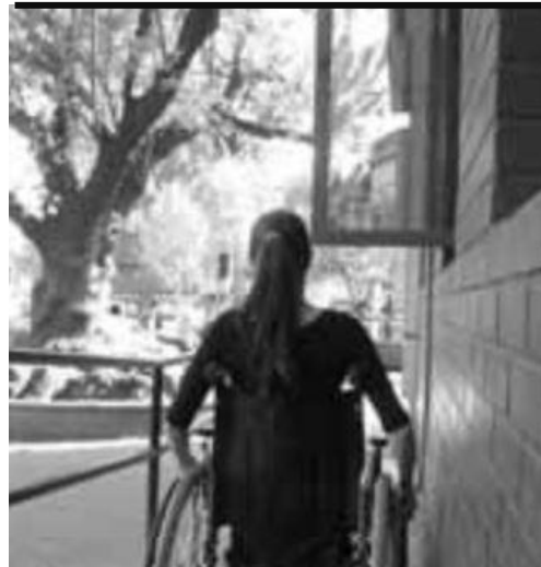
Ventana obstructora de una rampa, lo ideal sería que se abriera hacia adentro o ser corredera (103)
