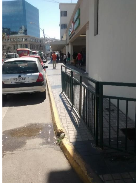
Barrera obstructora de calzada (118)
