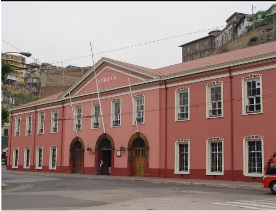
Fachada Edificio de la Dirección Regional Aduanas de Valparaíso. (104)
