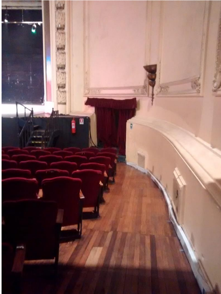
Pasillo inmediato a acceso lateral desde Pedro Montt (110)
