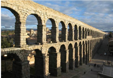
Sección del Acueducto de Segovia, donde alcanza su mayor altura los 28 metros (90)
