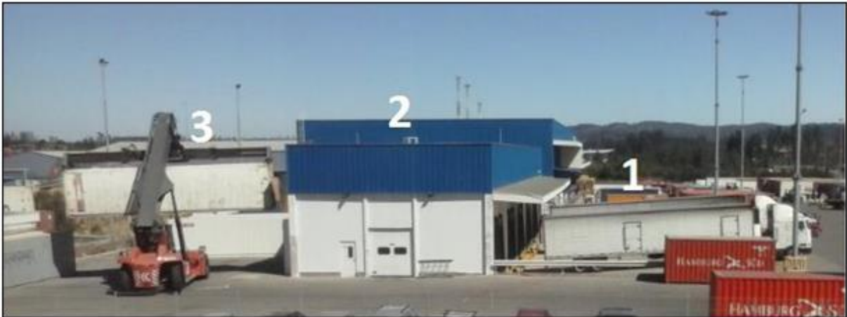
Figura 2.4 – Sector de trasvasijado en TEXVAL.
