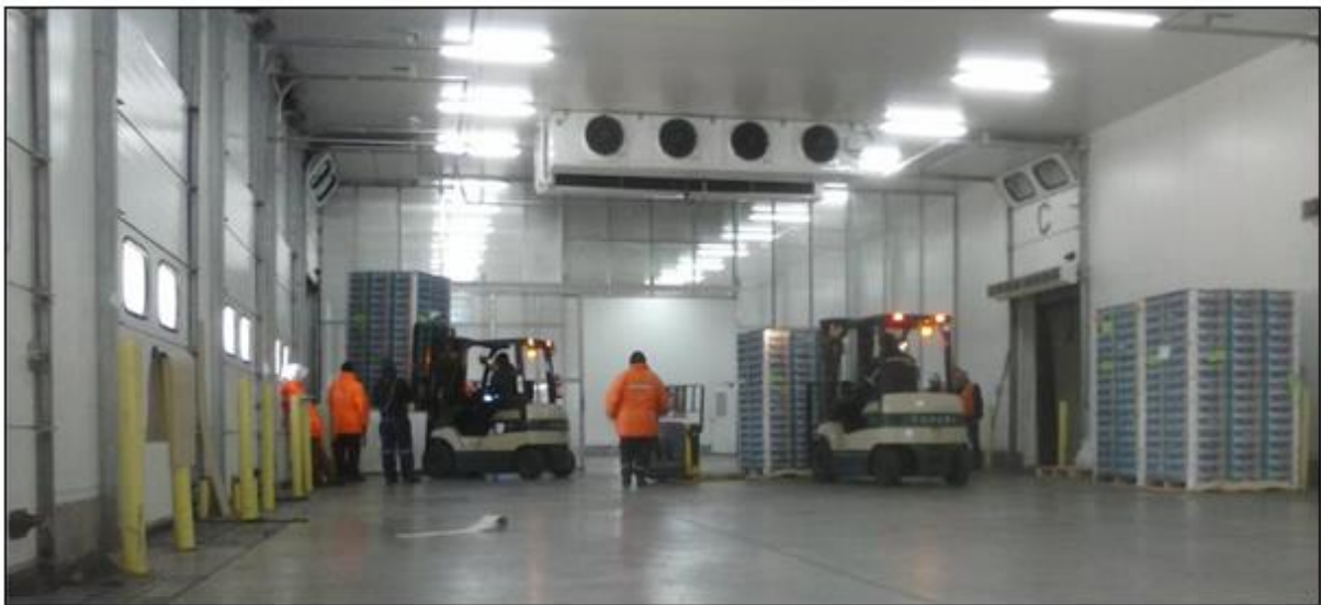
Figura 2.5 – Interior de Cámara de frío de TEXVAL.
