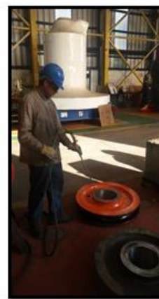
Preparación de calentamiento de polea padlock para el calaje de bujes.
