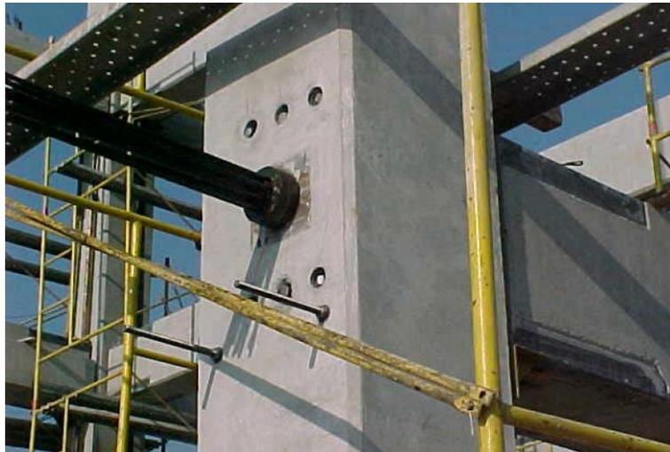
*Figura n° 1.1 - “Detalle columna de borde de un edificio con conexiones híbridas [1].”*
