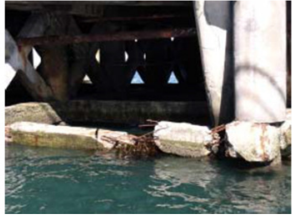
Daño típico en las vigas transversales inferiores del puente de acceso.
