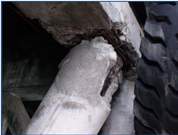
Agrietamiento severo en pilote inclinado. Armadura expuesta y pérdida de hormigón. Pilote vertical con agrietamiento menor. Viga longitudinal sin daño aparente.
