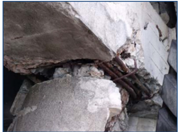
Agrietamiento severo en pilote inclinado. Armadura expuesta y pérdida de hormigón. Pilote vertical con agrietamiento menor. Viga longitudinal sin daño aparente.
