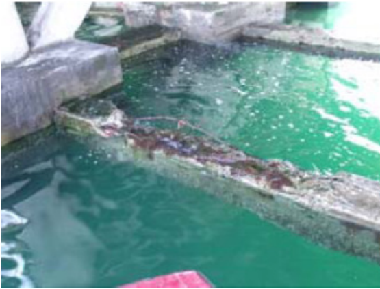
Daño típico en las vigas transversales inferiores del puente de acceso.
