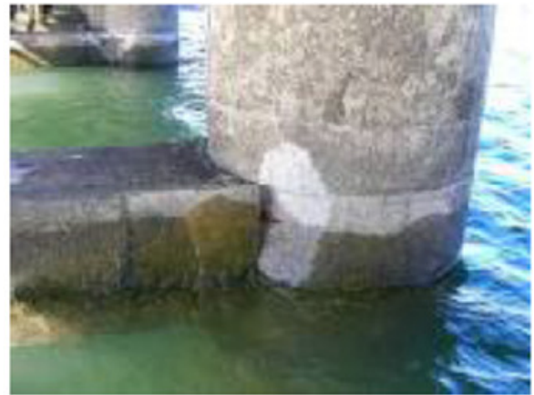
Daño severo en la conexión de la viga con el pilote inclinado. Armadura expuesta y pérdida de hormigón. Daño severo en la viga longitudinal. Pilote vertical con agrietamiento menor.
