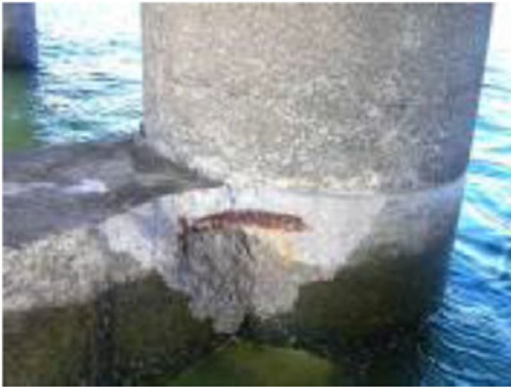
Daño severo en la conexión de la viga con el pilote inclinado. Armadura expuesta y pérdida de hormigón. Daño severo en la viga longitudinal. Pilote vertical con agrietamiento menor.
