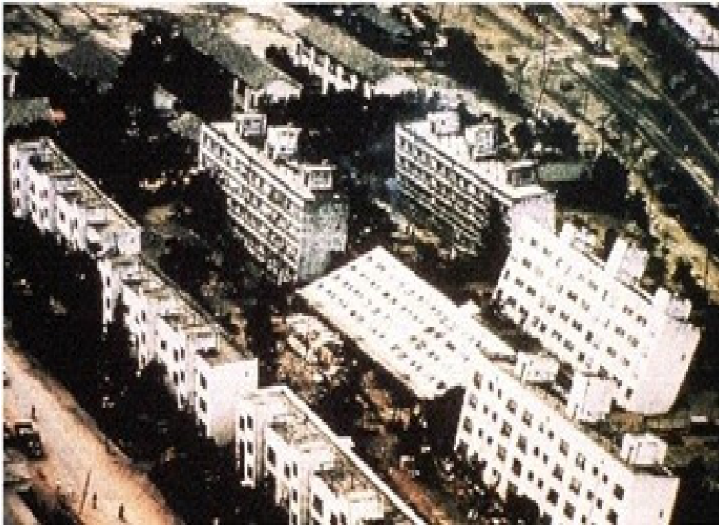
Figura 3-14, Daños por la licuefacción de suelos durante el terremoto de Niigata, Japón 1964 Fuente: (Gutiérrez I. , s/f)
