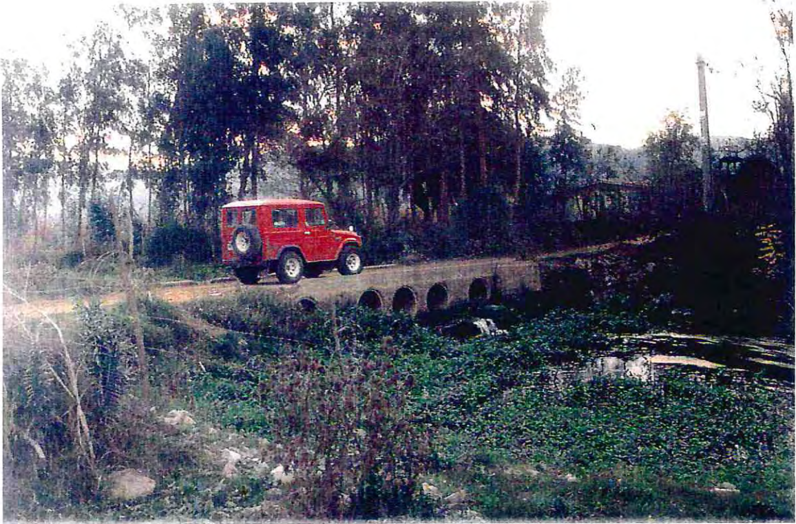
Infraestructura comunitaria: Puente sobre el canal de Pucalán. En el invierno el canal se desborda aislando completamente a los vecinos del sector.
