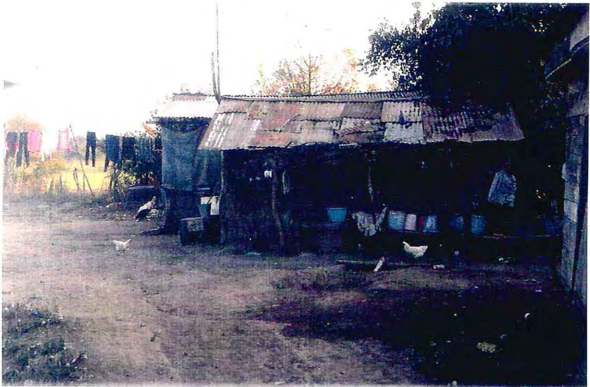
Casa de adobe, con piso de tierra y techo de material de desecho, construcción característica del sector rural de Los Caleos.
