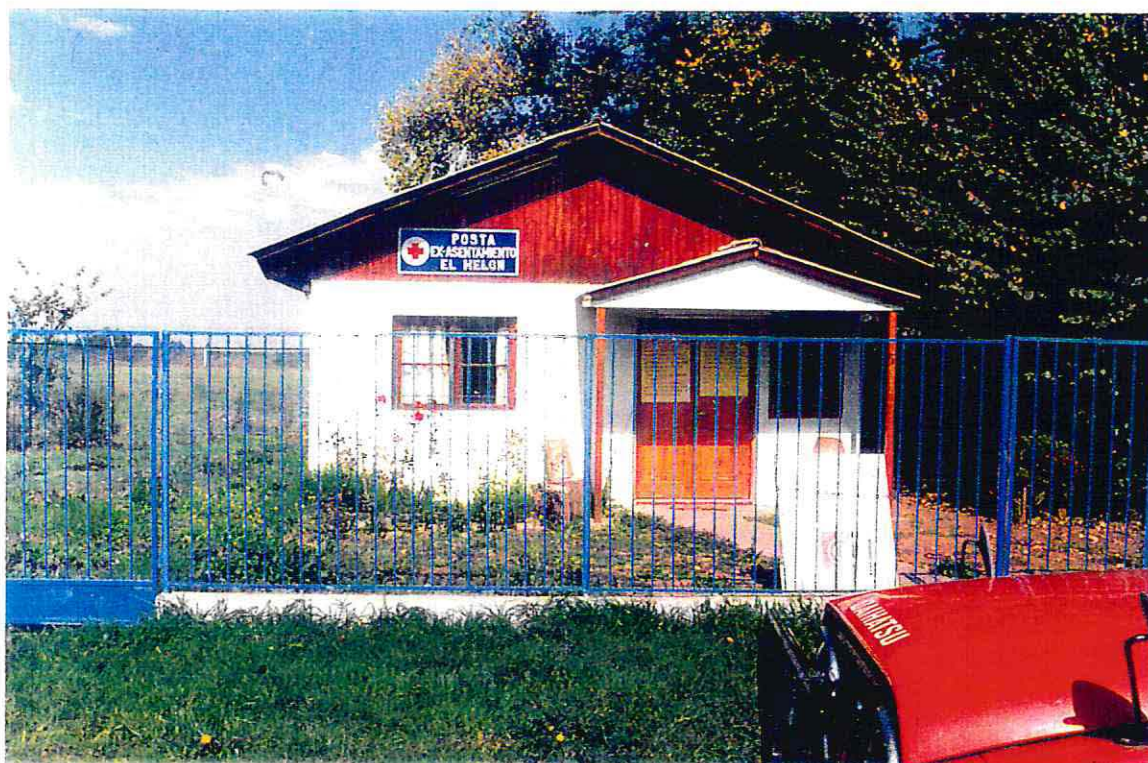
Posta Rural Ex Asentamiento El Melón, lugar de funcionamiento de la Oficina Rural Móvil.
