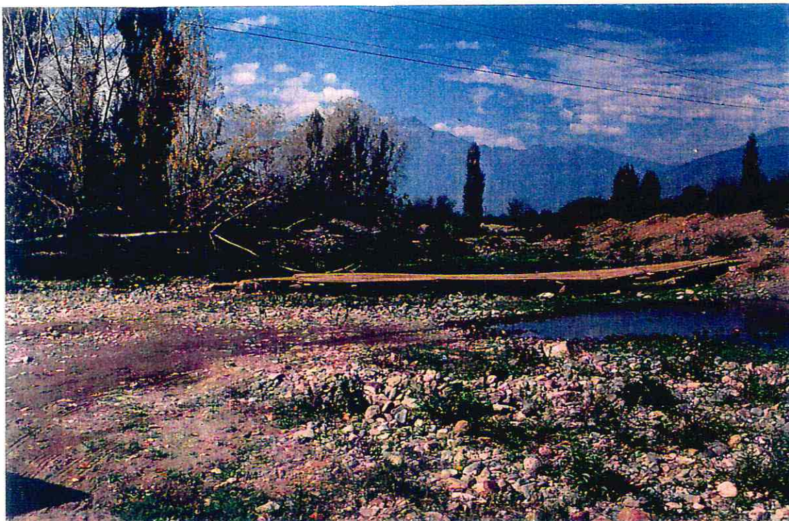
puente peatonal sobre el estero de la localidad de Las Palmas. Dicho paso se desborda en época invernal, aislando completamente a la población. En la actualidad los vecinos del sector se han adjudicado un proyecto de mejoramiento que permitirá realizar un estudio técnico para la construcción de una pasarela peatonal.
