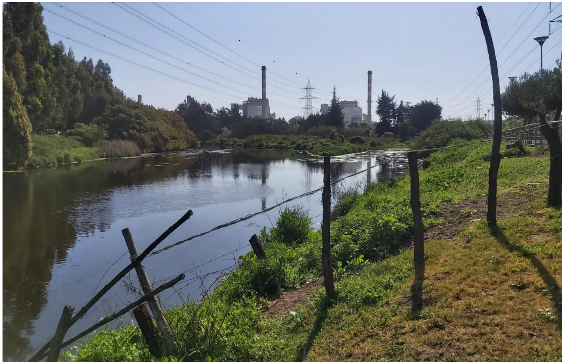
Figura 5.41: Cercado en mal estado que se encuentra emplazado en el sector "Las Salinas Poniente". Fuente: (Elaboración propia).
