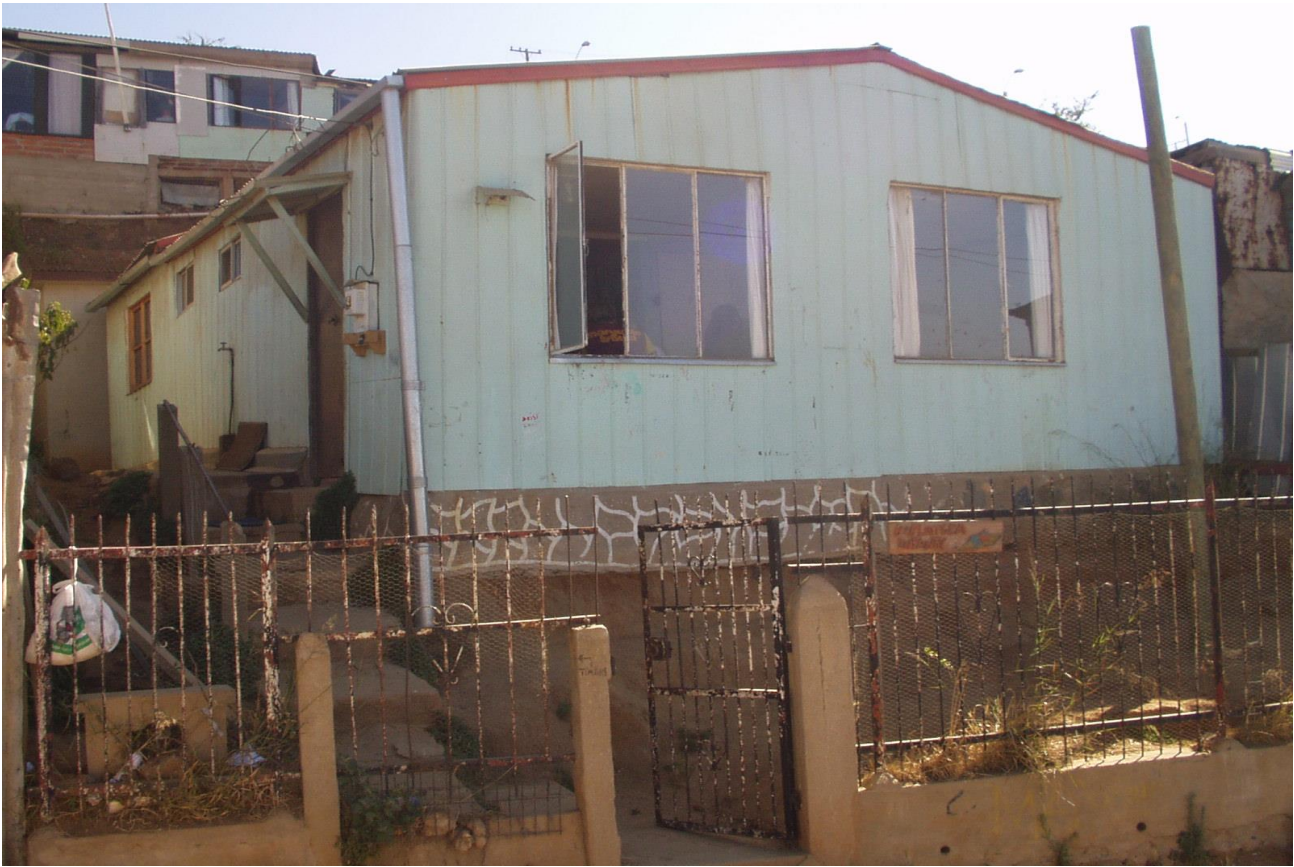
Fachada del Centro
