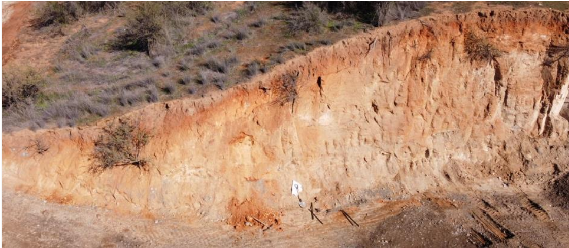
Figura 4.1 - Talud del sector de estudio – El Pangal. Fuente: Elaboración propia.
