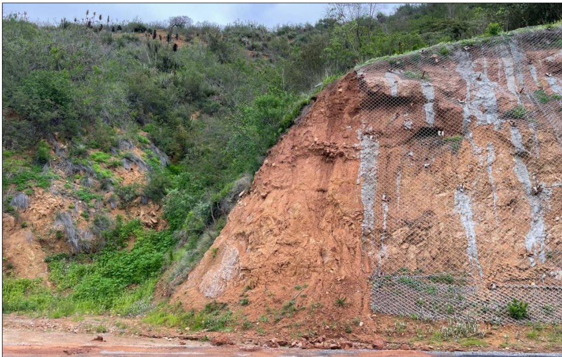
Figura 4.2 - Talud del sector de estudio – Camino La Quebrada. Fuente: Elaboración propia.
