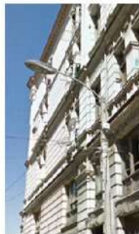
Concreto con luminaria
