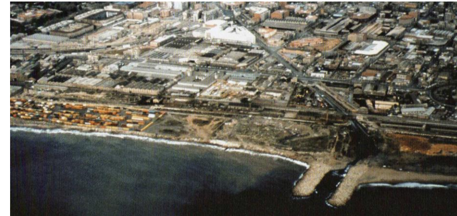
El frente de la costa 1987 con instalaciones obsoletas, contenedores del puerto en las playas
