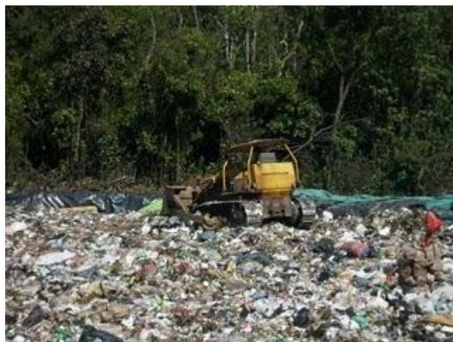
Se separan los residuos orgánicos de los inertes y se colocan en celdas de relleno
