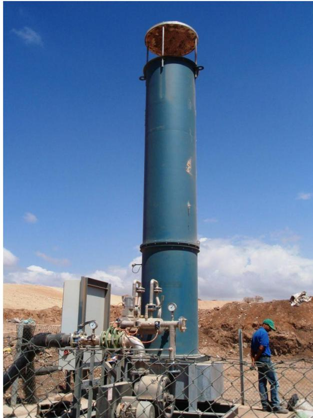
Las celdas de relleno sanitario están conectadas por tuberías, que conducen las emisiones hasta una antorcha, en donde son quemadas y convertidas en vapor de agua
