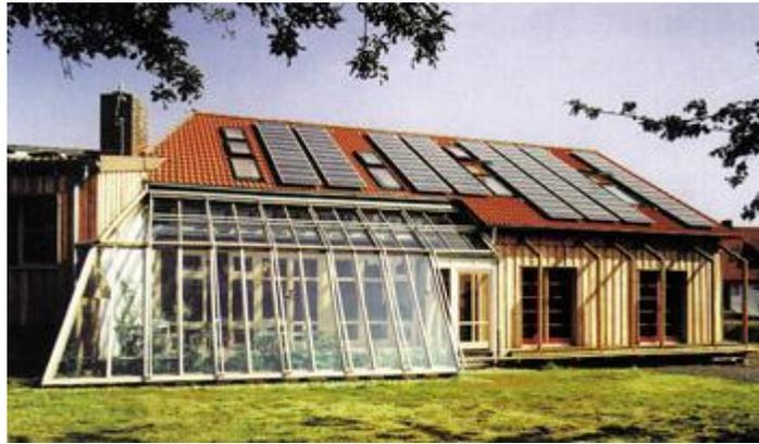
**Imagen 1: casa con invernadero y colectores de placa plana en el tejado**
