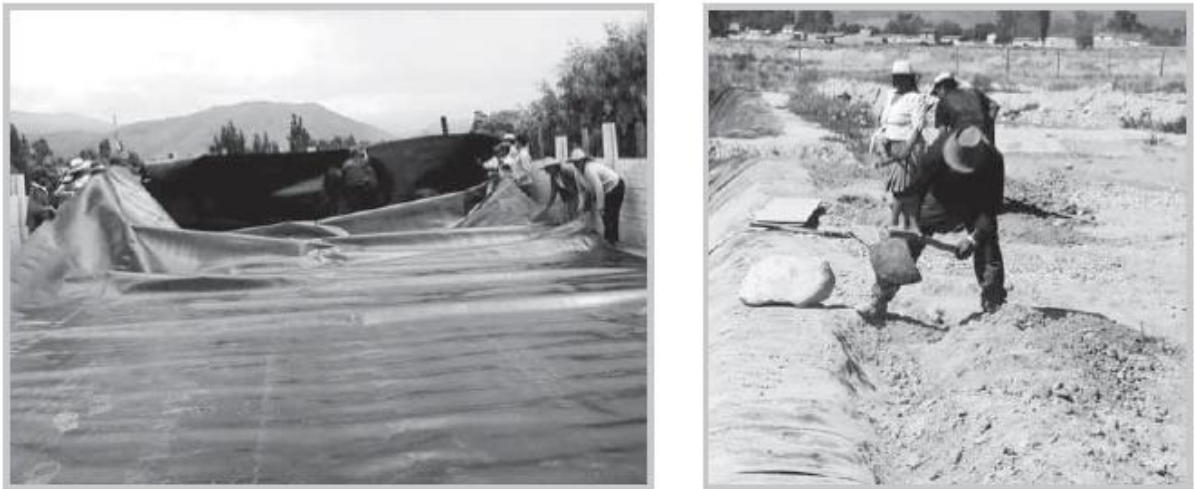
Figura 24 Tendido y anclaje de la geomembrana (Delgadillo et al. , 2010)
