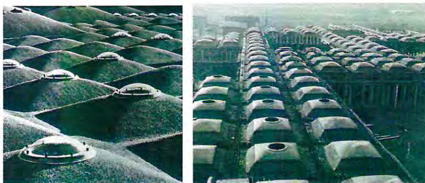
Figura 106. Aldo van Eyck, fotografías de la cubierta durante su construcción y una vez acabada.
