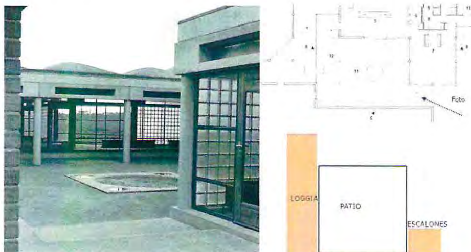
Figura 97. Aldo Van Eyck, fotografía del patio en la unidad para niños de 4-6 años.
