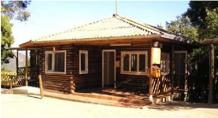
Caseta de control del guardaparque
