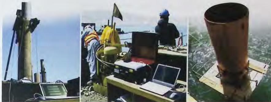
Fig. 2.3 - Hincado de pilotes de acero, con sistema especializado de sensores y procesamiento de datos.
