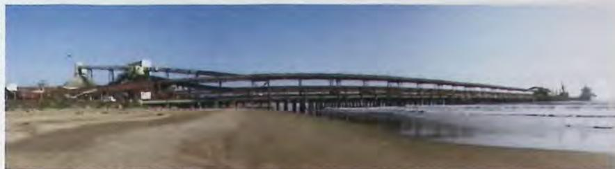
Fig. 2.2 - Ejemplo de muelle transparente, en Puerto Ventanas, Chile.
