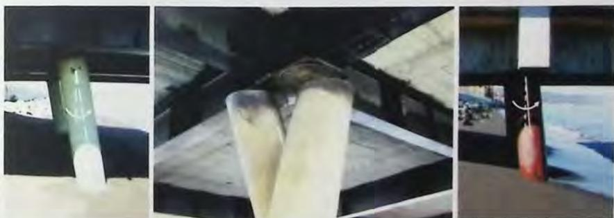
Fig. 2.6 - Ejemplo de daños estructurales. Inclinaciones y fallas de corte en unión viga-pilote.
