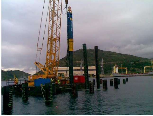
Figura 6. Faena de hincado de pilotes.
