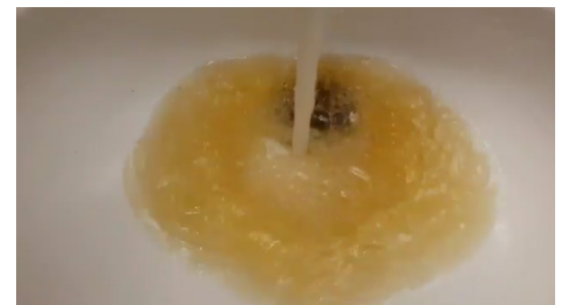
IMÁGENES DEL 2 DE MARZO DE 2017, DONDE POR APROXIMADAMENTE 4 DÍAS EL AGUA POTABLE LLEGABA A LOS HOGARES DE CONCÓN EN ESTAS CONDICIONES EVIDENTEMENTE CUESTIONABLES QUE GENERAN UN RECHAZO VISUAL INMEDIATO E INACEPTABLE.
