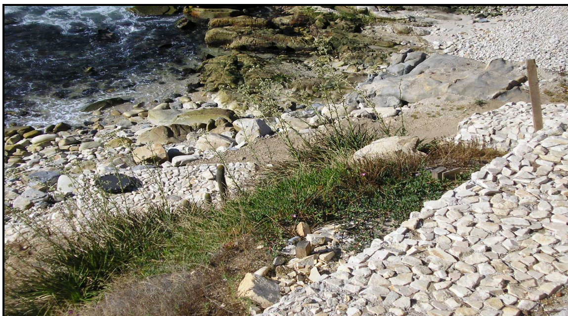
Foto 9. Cámara de descarga de Emisario Submarino ESVAL.
