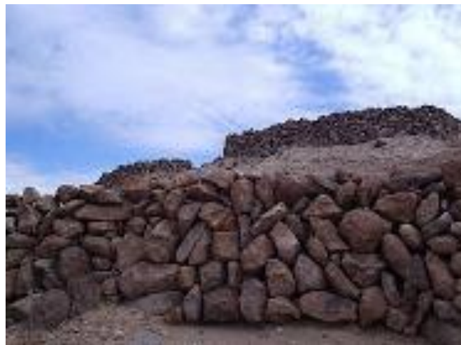
Muros de piedra Diaguitas.
