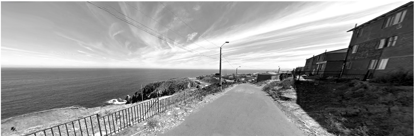
POBLACIÓN COSTA BRAVA, UBICADA EN EL SECTOR DE PORVENIR BAJO, VIVIENDA SOCIAL, DEPARTAMENTOS.
