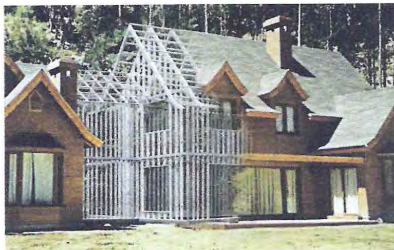
Figura 3.6- Vivienda compuesta de paneles estructurales [14]
