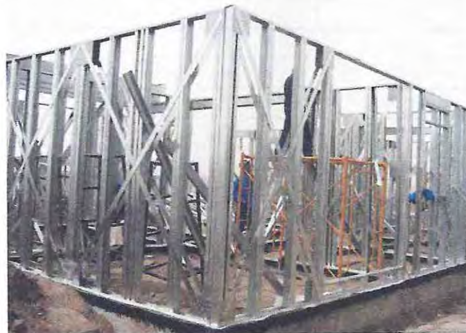
Figura 3.5- Panel estructural con diagonales
