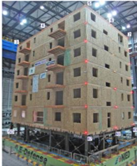
Figura 3.1 - Edificio de prueba [21]
