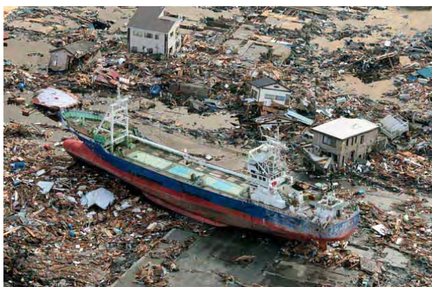
Fig. N° 133. Efectos del terremoto y tsunami de 2011, en Japón.
