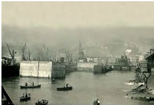
Fig. N° 77. Construcción del molo de abrigo en 1917.
