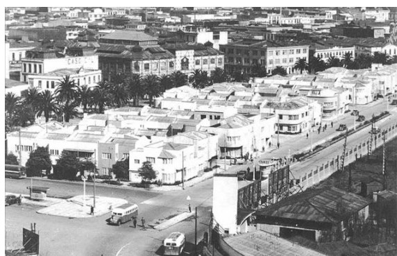
Fig. N° 86. Poblaciones construidas a los pies del cerro Barón.
