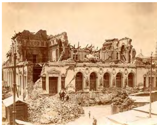
Fig. N° 147. Daños del terremoto de 1906 en el teatro de La Victoria. Fuente: Memoriachilena.cl.
