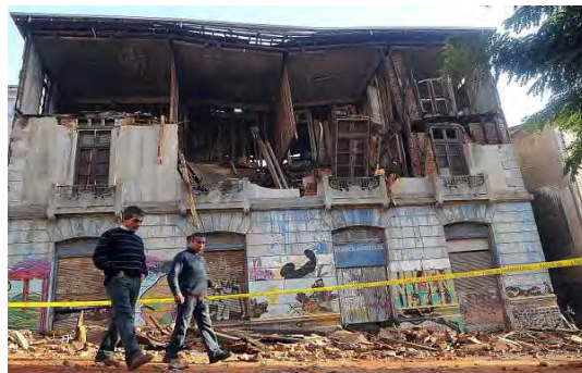
Fig. N° 154. Casas dañadas en El Almendral el 2010.
