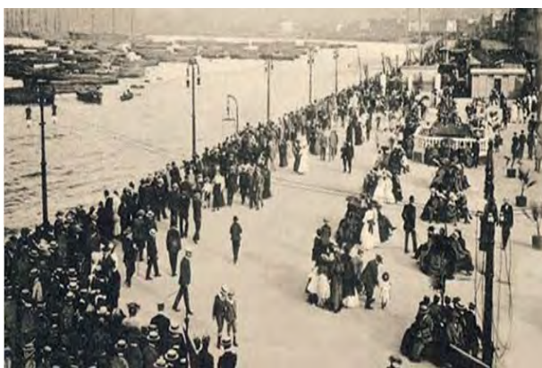
Fig. N° 198. Inauguración del paseo costero, en avenida Errázuriz.
