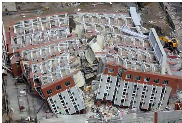
Fig. N° 161. Edificio Alto Río derrumbado en Concepción el 2010.
