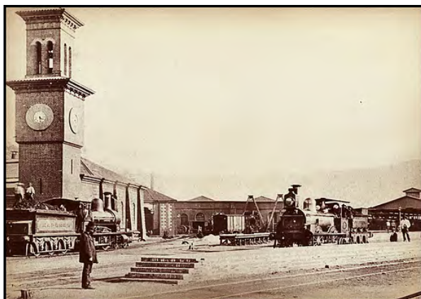
Fig. N° 87. Estación Barón, de la cual sólo se conserva la torre de ladrillos.
