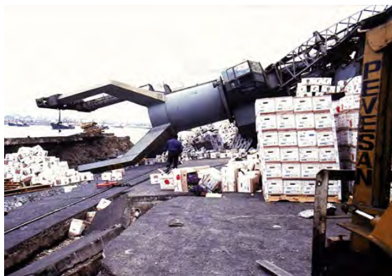
Fig. N° 145. Daños del terremoto de 1985 en el puerto de San Antonio.
