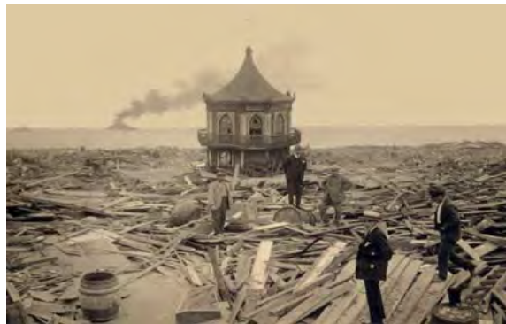
Fig. N° 157. Efectos del terremoto y tsunami de 1922 en Chañaral.
