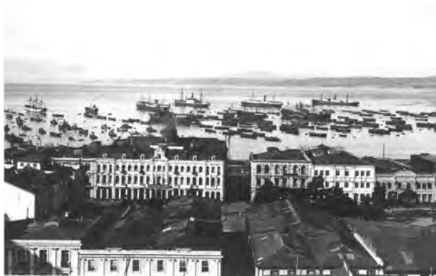
Fig. N° 140. Naves fondeadas a la gira en Valparaíso, cuando aún no existía el molo de abrigo.
