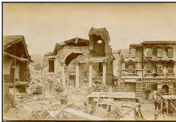
Fig. N° 73. Iglesia de La Merced tras el terremoto de 1906.
