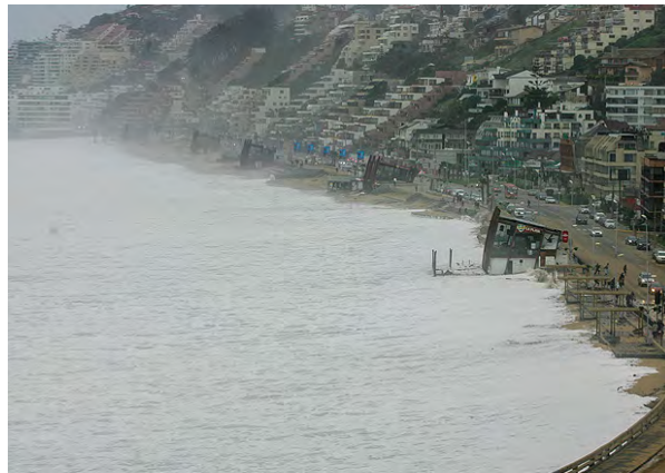
Fig. N° 144. Efectos de la marejada en Reñaca.
