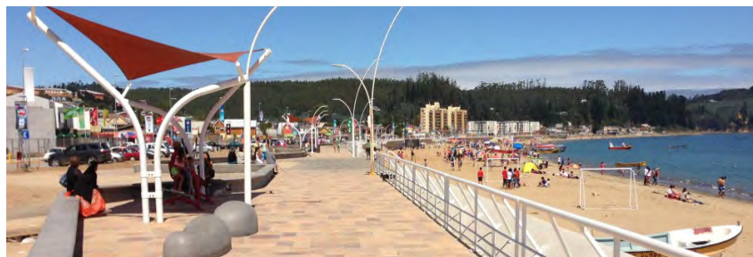
Fig. N° 166. Playa de Dichato con obras de mitigación.
