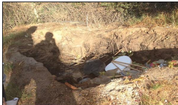
Figura 8.2 - Foso Cementerio Parque de Boco
