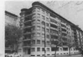
Edificio Parque Forestal León Prieto C.
