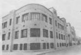
Consultorio SNS/Calle Copiapó
