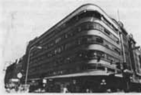
Edificio Oberpaur S. Larrain G.M. - J. Arteaga
