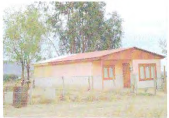
Fotografía N°17 “Vivienda levantada por autoconstrucción”
