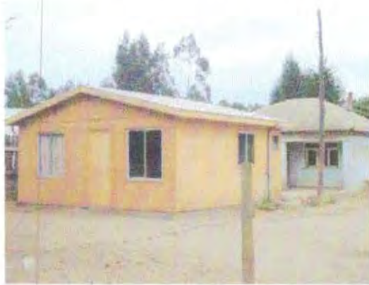
Fotografía N°16 “Vivienda construida por encargo a empresa constructora”
