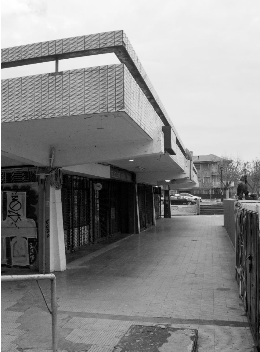
Fig.43: Frente de los locales comerciales semi enterrados, se aprecia la estructura de hormigón y las barandas con cerámicos de la plaza que se extiende sobre los locales. Fuente: Fotografía de elaboración propia
