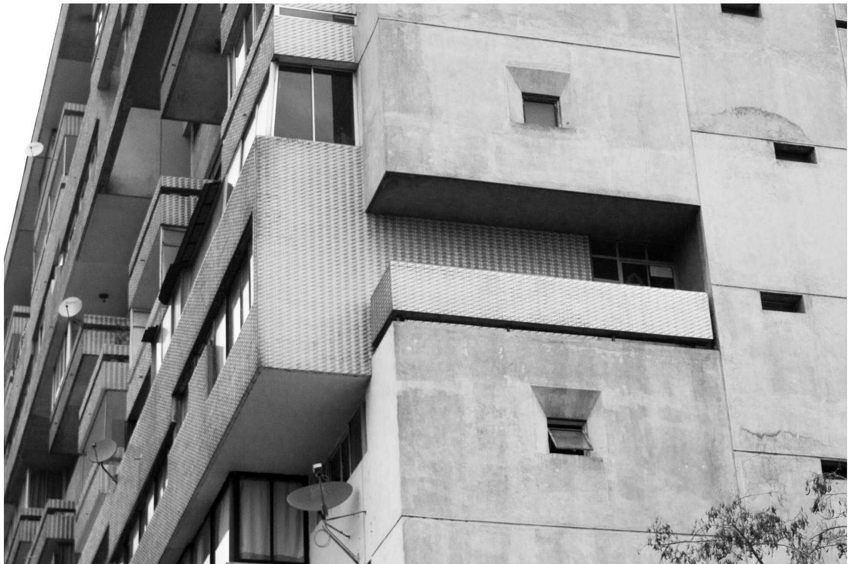
Fig.45: Retranqueo de la fachada y vanos que responden a características funcionales: Fotografía de elaboración propia
