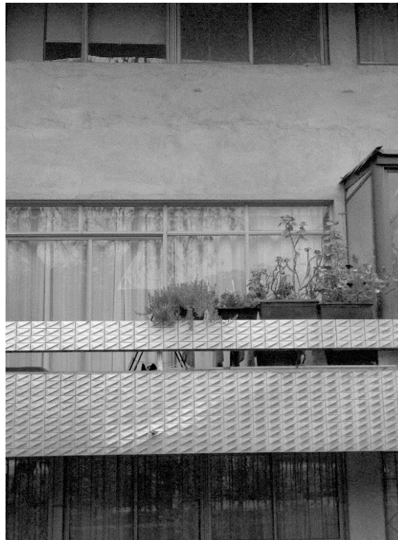
Fig.40: Acercamiento de la cerámica utilizada para la baranda de la plaza sobre el techo de la placa comercial. Fuente: Fotografía de elaboración propia.
