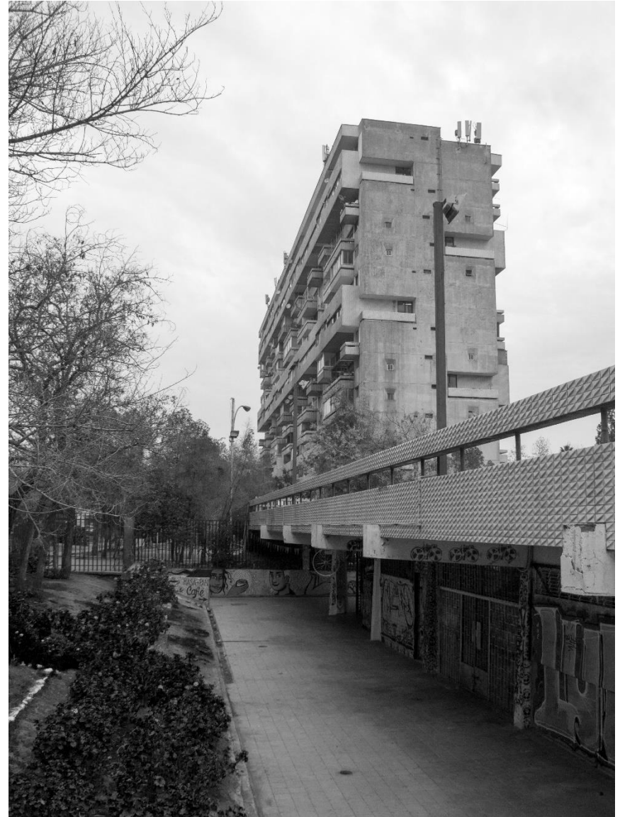
Fig.43: Frente de los locales comerciales semi enterrados, se aprecia la estructura de hormigón y las barandas con cerámicos de la plaza que se extiende sobre los locales. Fuente: Fotografía de elaboración propia
