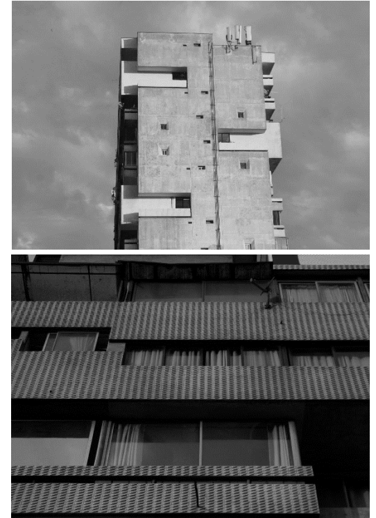
Fig.38: La cerámica que recubre los volúmenes horizontales de los departamentos simplex. Fuente: fotografía de autoría propia.
