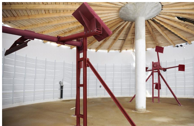
Figura 6.20: Agitador agriKomp PADDELGIGANT. (Fuente: agrikomp).
