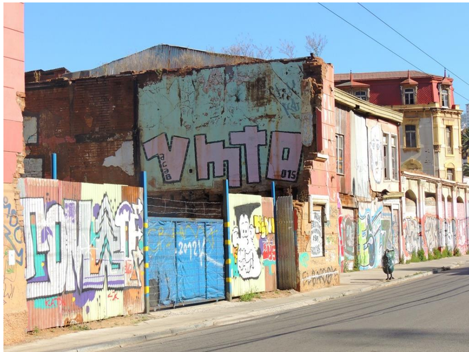
Imagen 9 Graffiti en sitio abandonado. Barrio Puerto.
