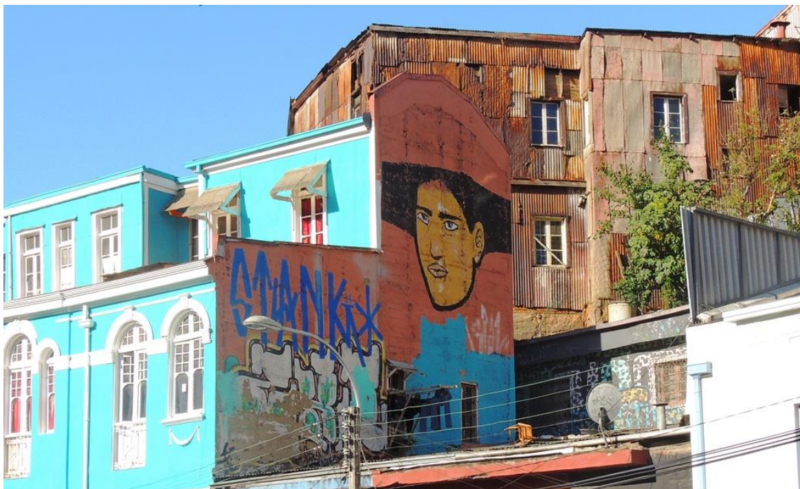
Imagen 16 Convergencia de intervenciones en un mismo espacio. Subida Ecuador.
