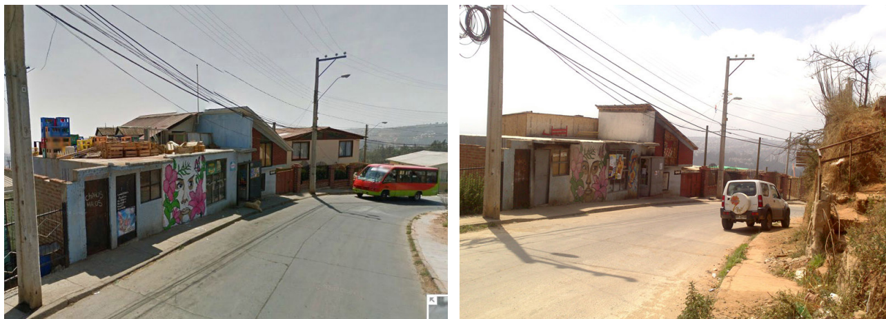
Fig. 13: Fotografías de antes y después del incendio de Valparaíso. Se aprecia la resiliencia de los habitantes que prefirieron reconstruir rápidamente su casa y no irse a vivir a otro sector. Cerro Las Cañas.
