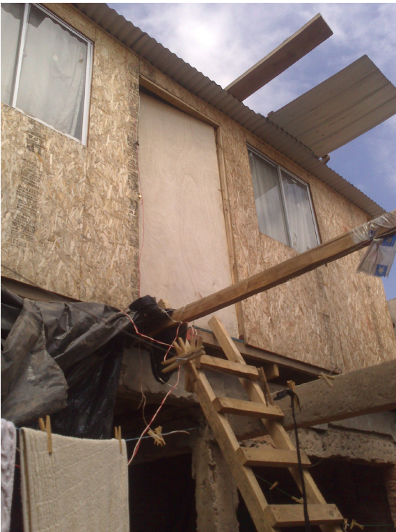
ARRIBA: VIVIENDA EN ESTADO DE RECONSTRUCCIÓN
