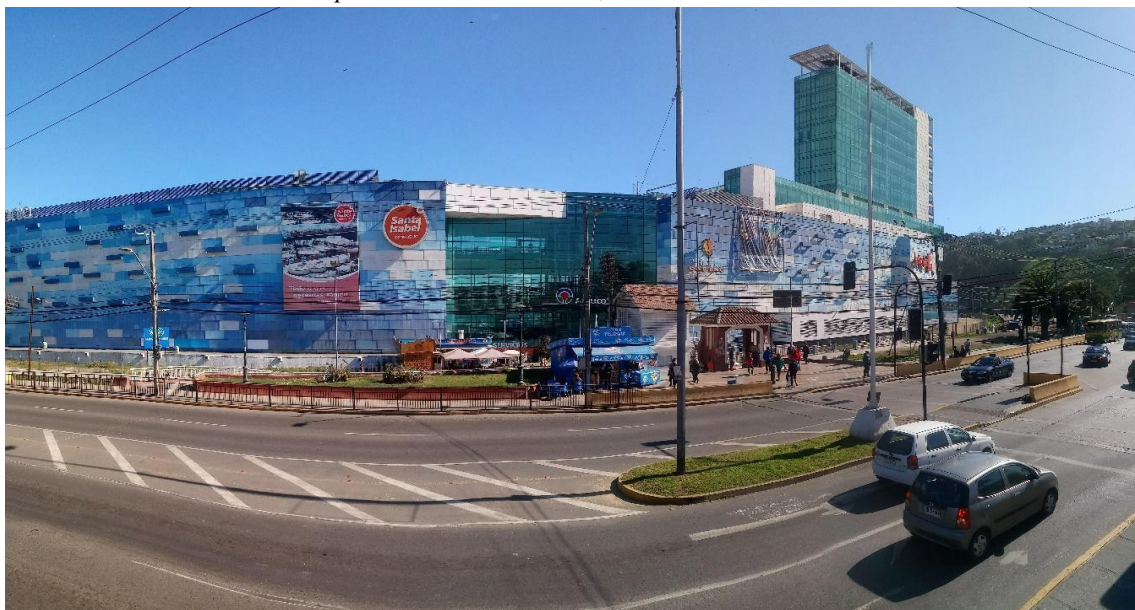
Fig.24. Vista del Mall Arauco San Antonio en el borde costero. Elaboración propia, 2019.
