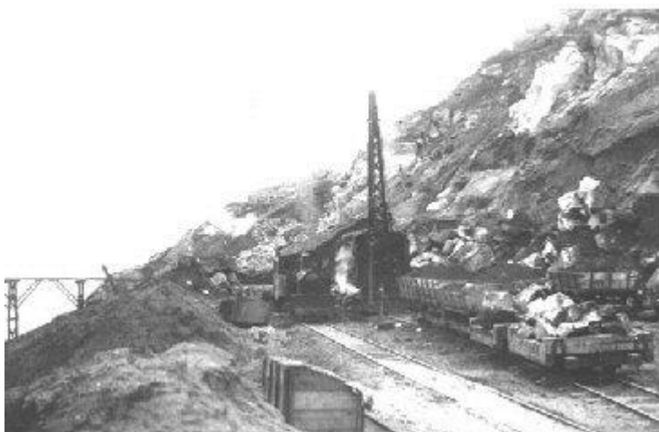
Fig.16. Construcción de la vía San Antonio - Cartagena. Trenvías, historia de la infraestructura ferroviaria en Chile.
