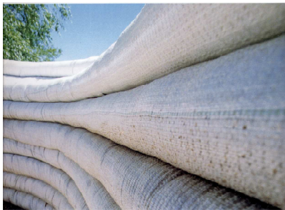
Cúpulas museo y centro de la naturaleza, arquitecto Nader Khalili
