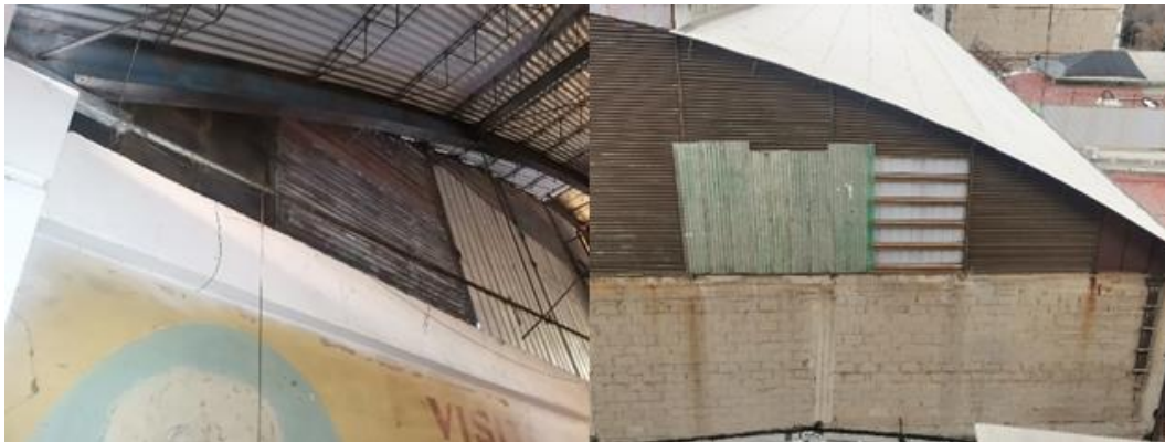
Figura 4.8 Vista interior y exterior del estado de la estructura, elevación oeste. Fuente: propia, 2025.
