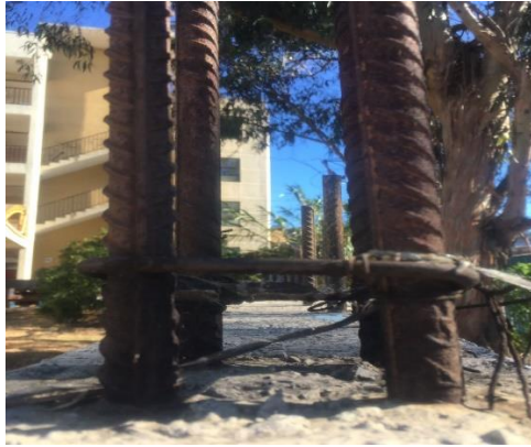
Figura 5.3 Capa de oxido Fuente: Elaboración propia
