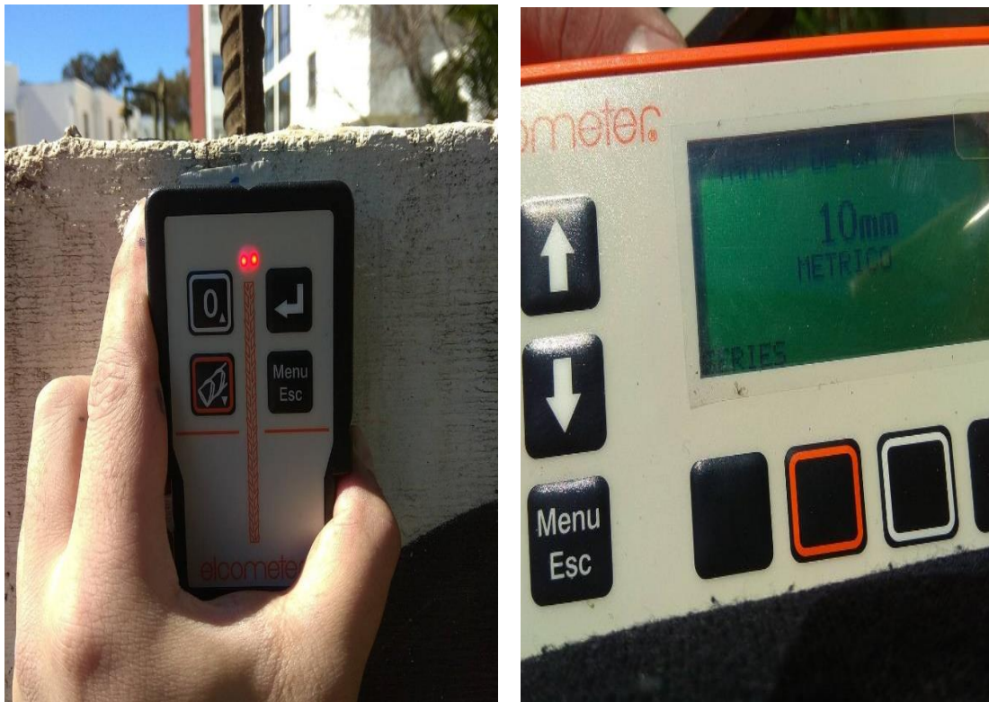
Figura 4.5 Detección de armaduras y espesores de recubrimientos
