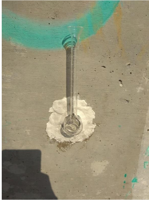
Figura 3.5 Instalación de tubo Karsten Fuente: Elaboración propia
