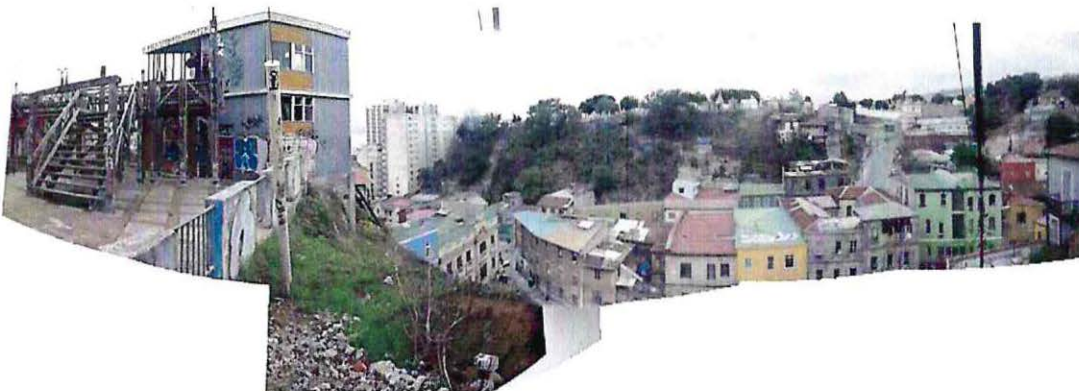
3. Estación Superior Ascensor Reina Victoria. Vista al Cerro Panteón (Cementerios)
