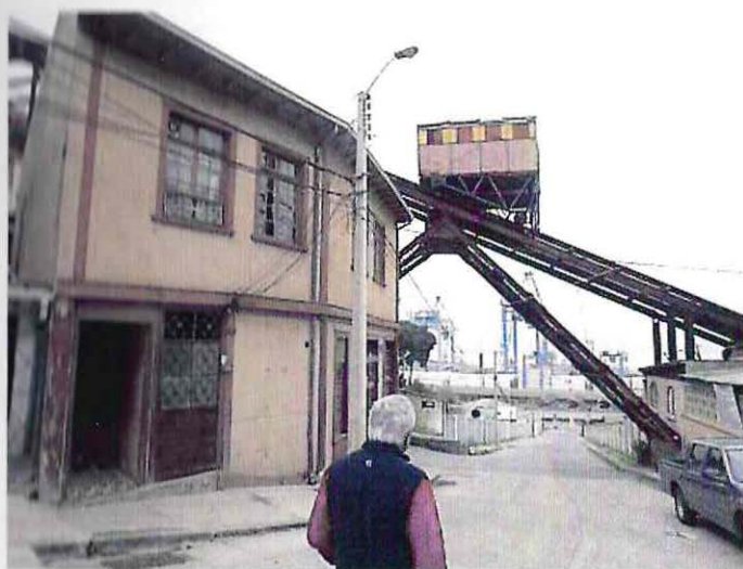
Imagen N°60 1.Vista Ascensor Villaseca, desde Taqueaderos, http://www.soychile.cl/Valparaiso/Sociedad/2011/04/29/11463/El-Gobierno-dispone-de-2-mil-millones-para-comprar-diez-ascensores-de-Valparaiso.aspx
