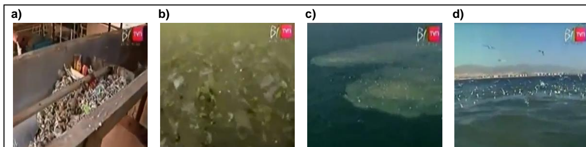
Figura 1-2: Emisario submarino de la bahía de Coquimbo. Diferentes capturas del proceso de vertido. a) Tratamiento físico, b) sólidos en el fondo, c) pluma de descarga desde el aire y d) aves atraídas hacia la pluma de descarga.
