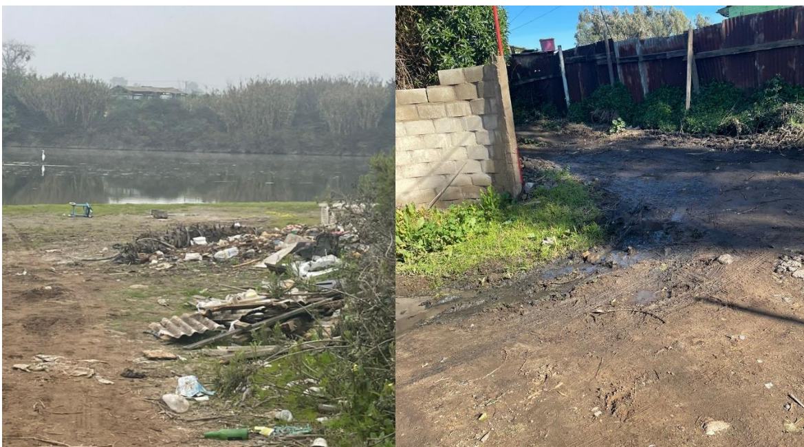
Figura 30; Generación de microbasurales y afloramiento de aguas negras por viviendas irregulares.
