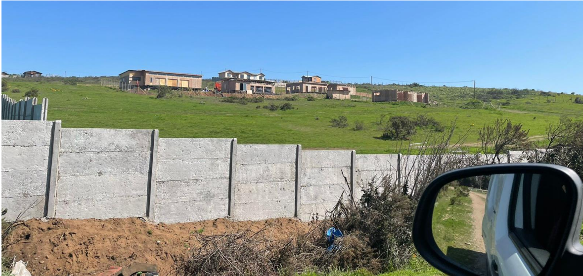
Figura 32; Viviendas en construcción a un costado del humedal urbano Los Juanes.
