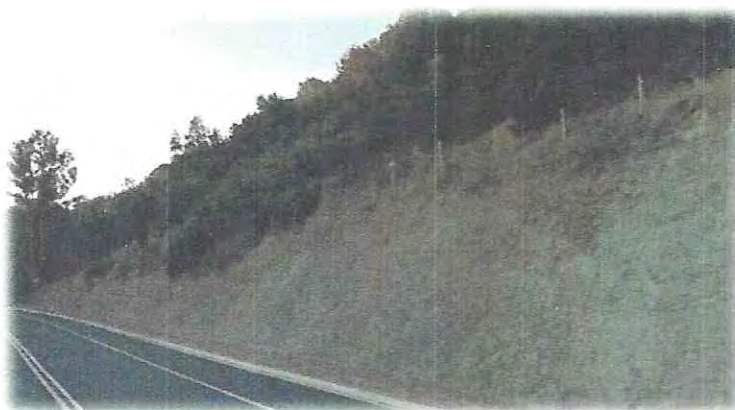
Figura 3-6 : Arena Limosa - Camino Lo Orozco
