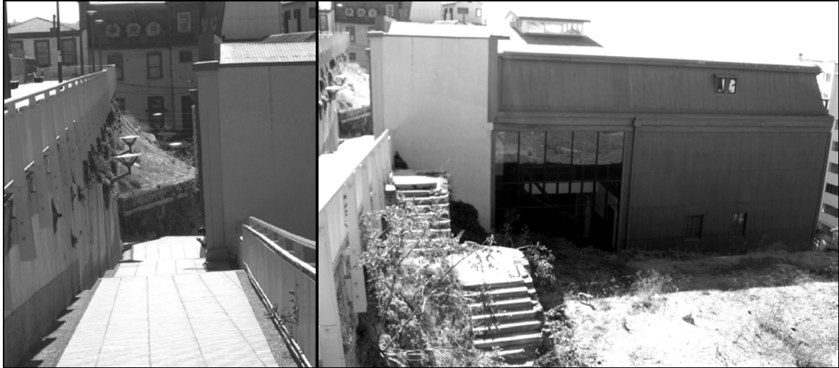
figura 39: CASONA DE SUBIDA CONCEPCIÓN 81, DE LOS TALLERES DE LA ESCUELA DE ARQUITECTURA.
