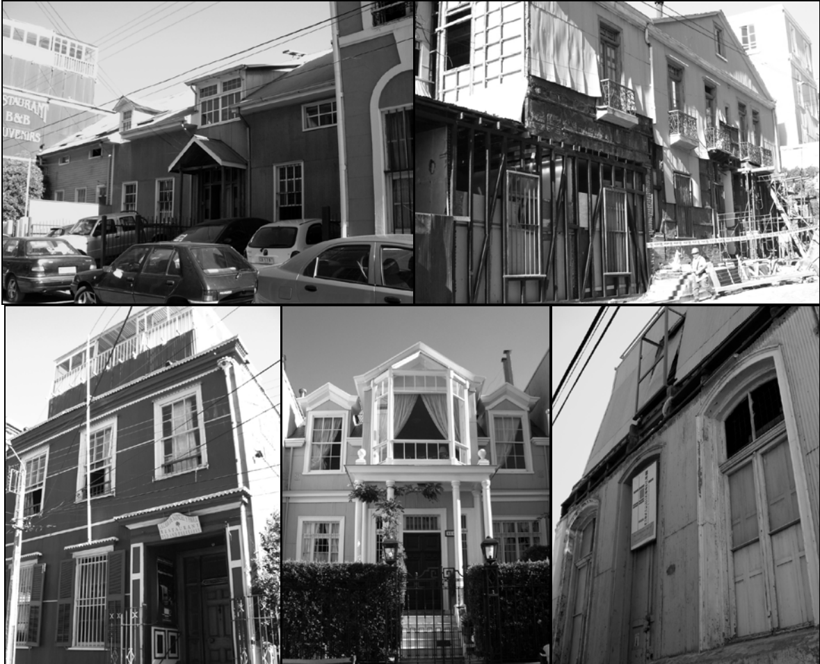
figura 24: EDIFICACIONES RECIENTEMENTE REMODELADAS (IZQ.) Y EN PROCESO DE REMODELACIÓN (DER.).
