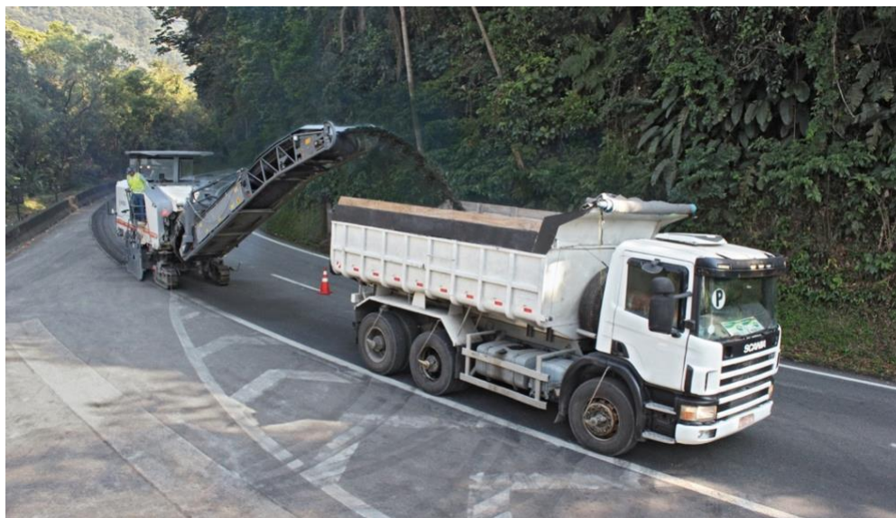
Figura 6.1.- Proceso de fresado (imagen referencial) [17].
