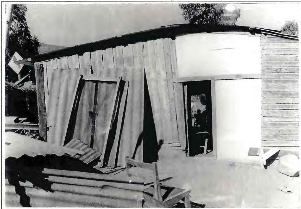
FIG. 16 FOTO DE LA FACHADA PONIENTE, VIVIENDA EN ILLAPEL.
