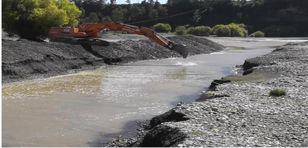
Figura 2.2: extracción desde cauce de río Fuente: Elaboración propia
