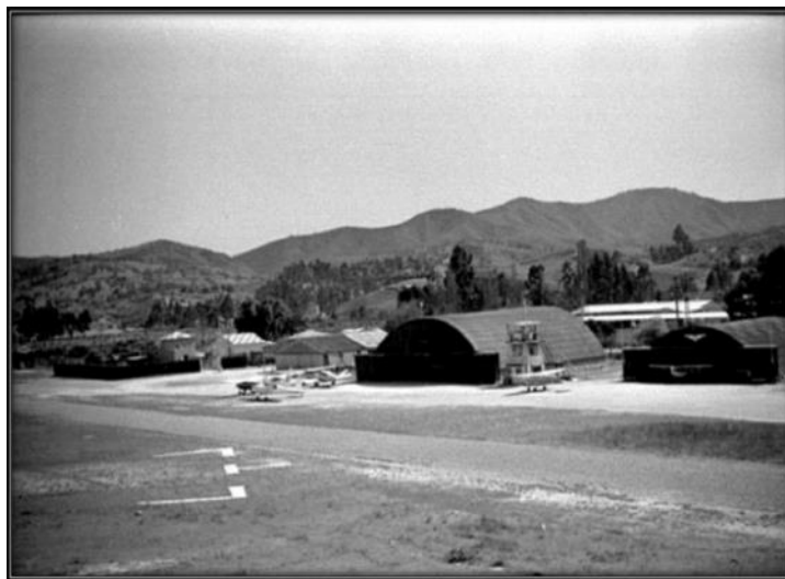
FIG.2 instalaciones de los clubes aereos « Aconcagua » y « universidad Santa maría » en la base aeronaval « El Belloto » en los años '60.
