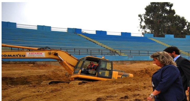
Figura 1: Remodelación estadio Sausalito (2013), BESALCO.
